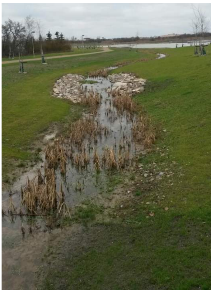
Figur 20. Brett och grunt dike med flacka sidoslänter (© Tyréns).
