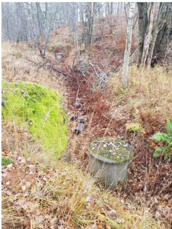
Figur 9. Brunnar i den torrlagda bäckravinen. Vattnet leds i en ledning eller kulvert mot sjön Gron. Vy mot söder.
