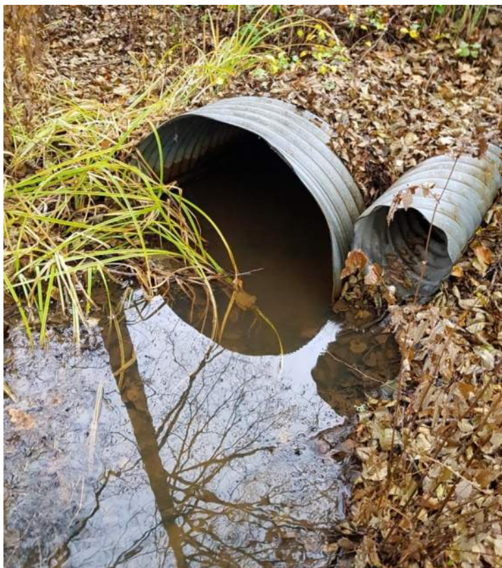
Figur 10. Utlopp av den större trumman under Östermalmsvägen, vy mot nordväst.
