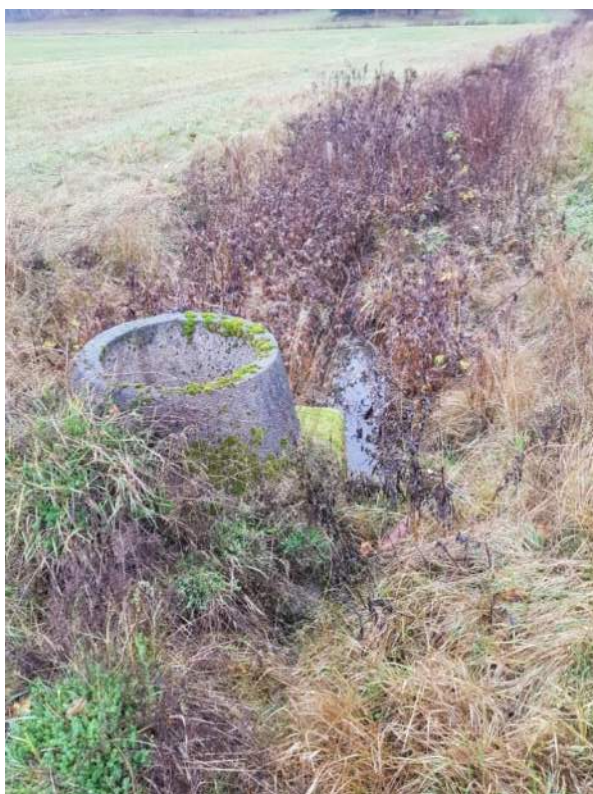
Figur 8. Hästhagsbäcken, brunn och inlopp för kulverten, vy mot norr.
